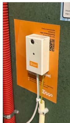
KPN en Ziggo aansluiting in meterkast
